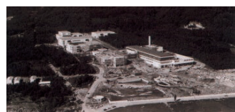
驹根工厂正在建设的情形
