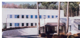
中央研究所新棟
